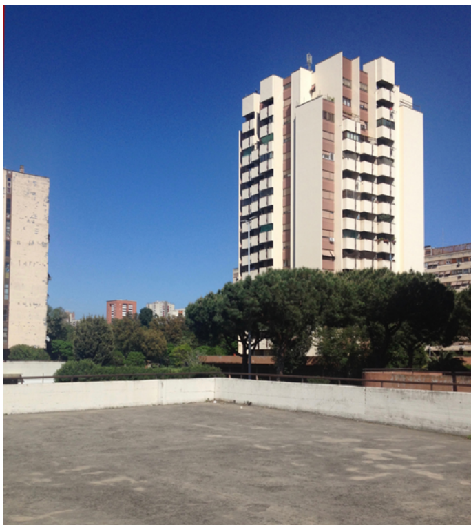
7. Edifici residenziali in periferia, Quartiere Laurentino, Roma (foto di Valerio Palma, Dicea-Unipd)
