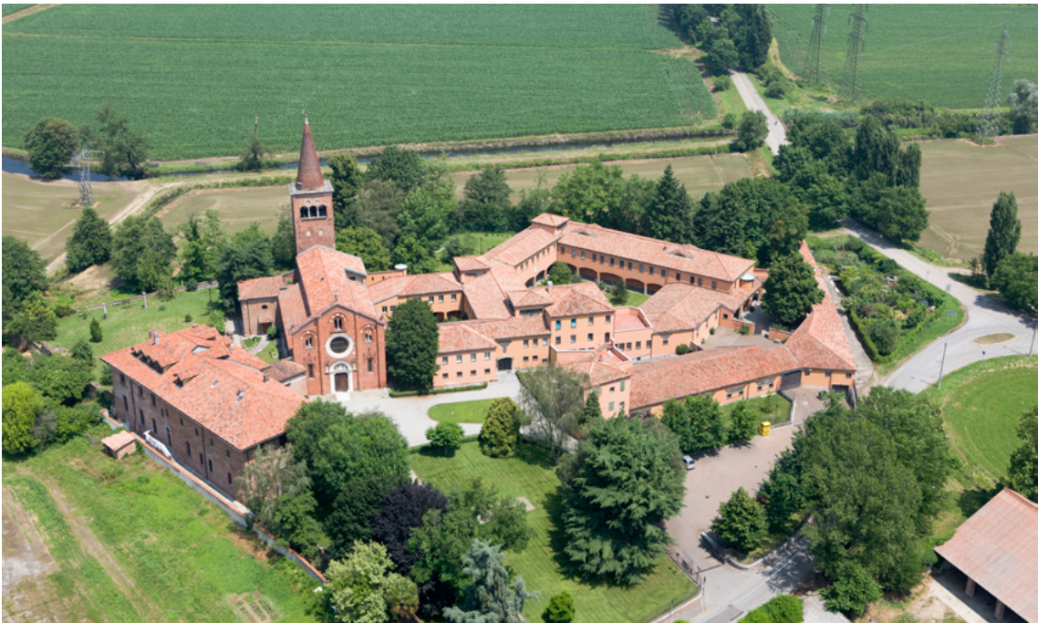
2. Viboldone, veduta aerea del complesso abbaziale (Archivio Abbazia di Viboldone)
