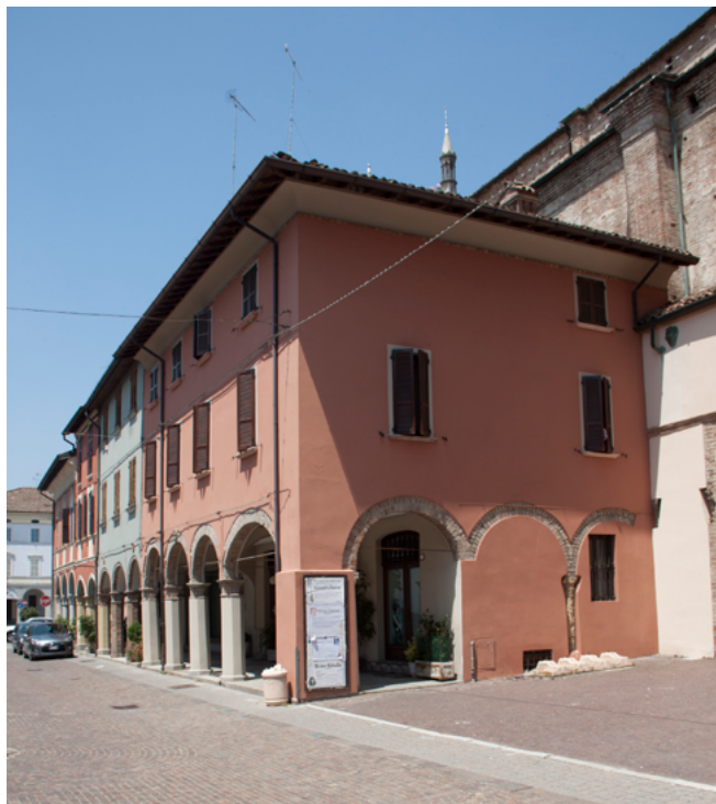
31. Resti dei portici del mercato coperto, in via Garibaldi, Cortemaggiore
