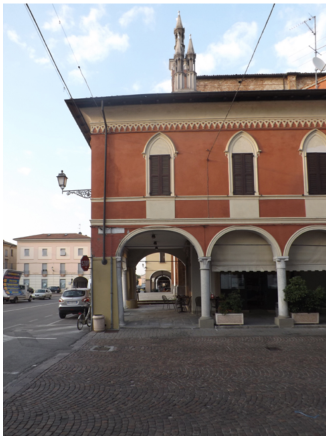
30. Edificio sul sito del mercato coperto, angolo via Garibaldi, piazza dei Patrioti, Cortemaggiore
