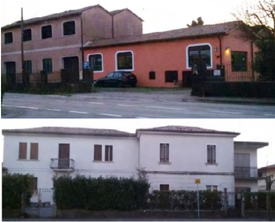
FIG. 16 - Gli edifici relativi alla rimessa e alla stazione di Pieve di Soligo come si presentano oggi.
