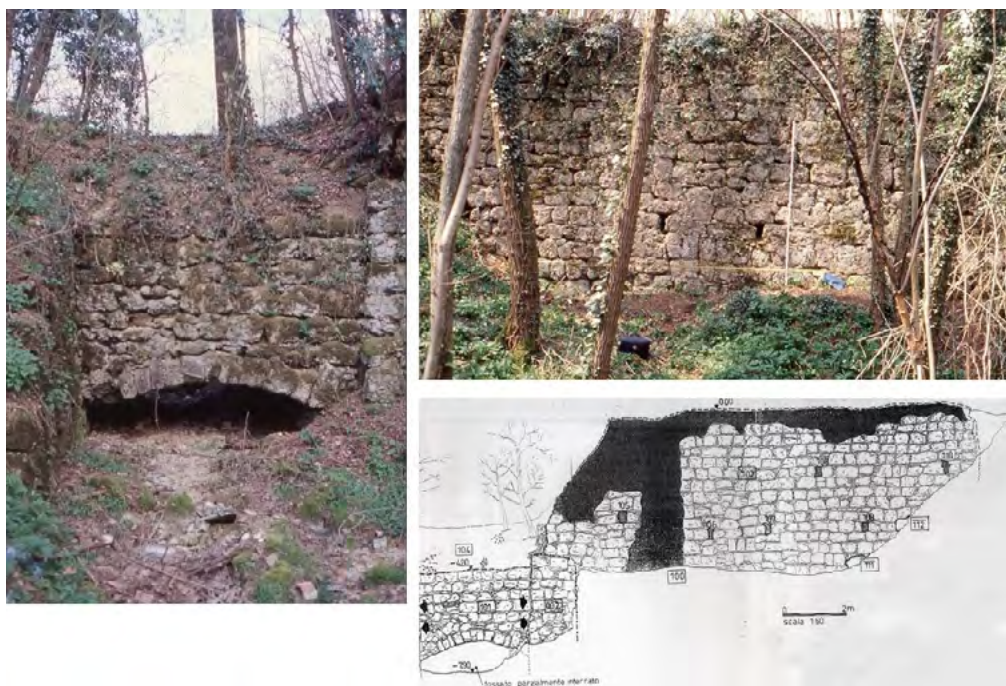
FIG. 4 - Il ponte sul rio Costana: strutture e rilievo dell'alzato (foto e rilievo di L. Mingotto).
