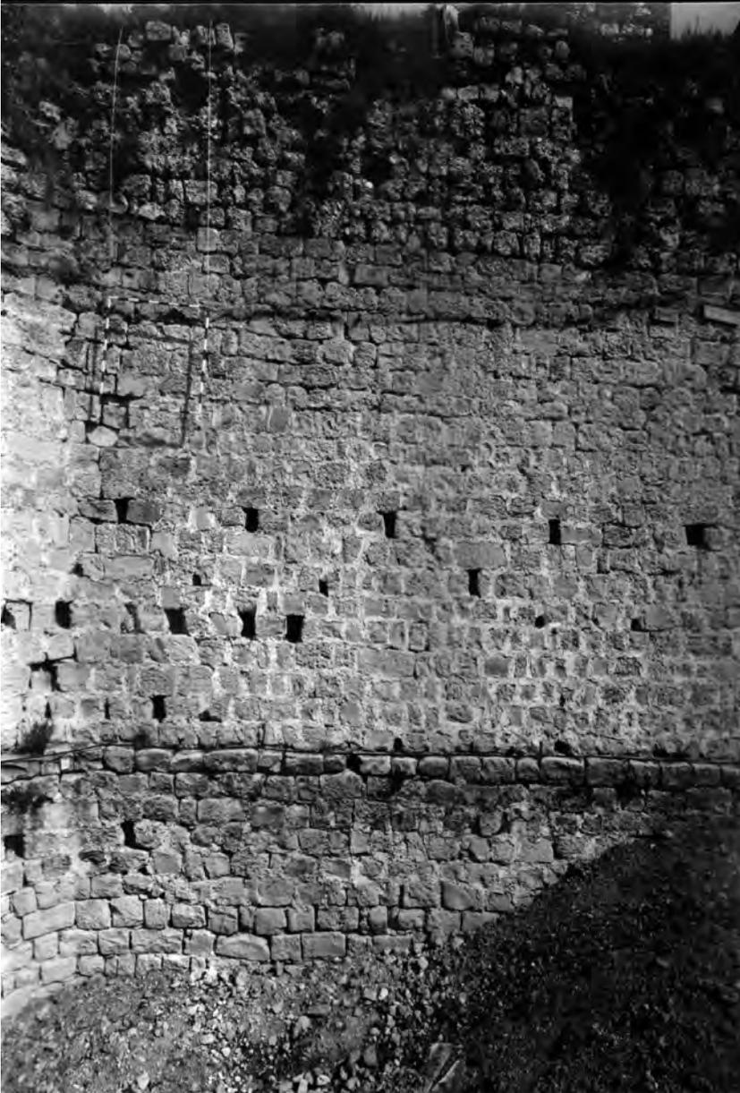
Fig. 47 - Fotopiano del paramento con fori pontai di un tratto del muro occidentale della Rocca (elaborazione di Edoardo Cipriano).
