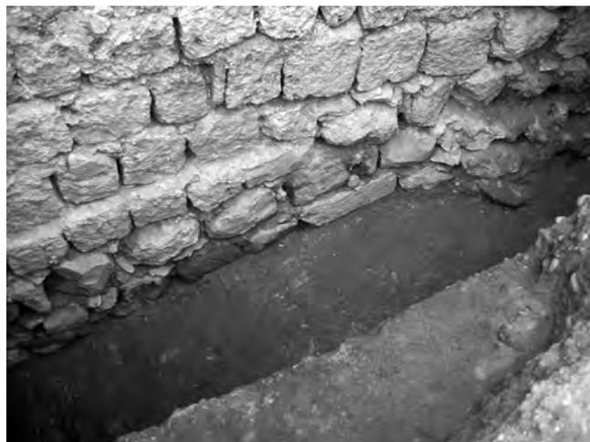
conglomerato, nei tratti indagati archeologicamente (saggi  $\gamma$ ,  $\epsilon$ ,  $\delta$ ), non presenta, come nel muro in arenaria, riseghe di fondazione, ma una muratura uniforme, che risulta anche di spessore leggermente inferiore (2.5 m) rispetto al tratto in arenaria (3 m).
