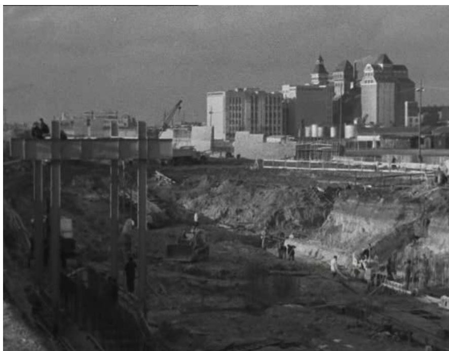
10. Il cantiere del Périphérique ( Métamorphoses du paysage ).
