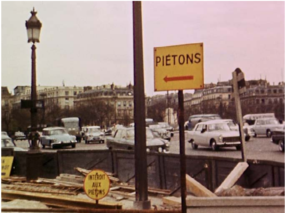
11. Il cantiere ( Place de l'Étoile ).
