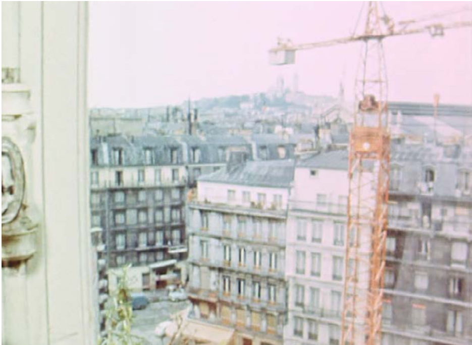
13. Il cantiere ( Gare du Nord ).
