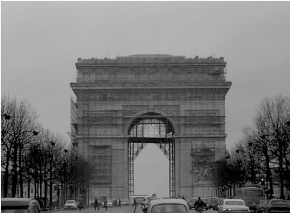
15. Il cantiere dell'Arc de Triomphe ( Brigitte et Brigitte ).
