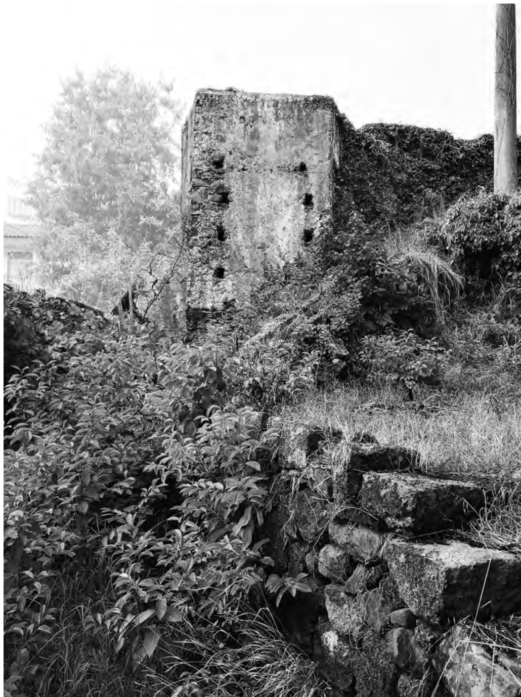
Fig. 1. Nunziata di Mascali (Catania). Prospetto della “Torre Acquedotto” di un mulino ad acqua non più esistente, nel territorio dell’antica Contea di Mascali.
