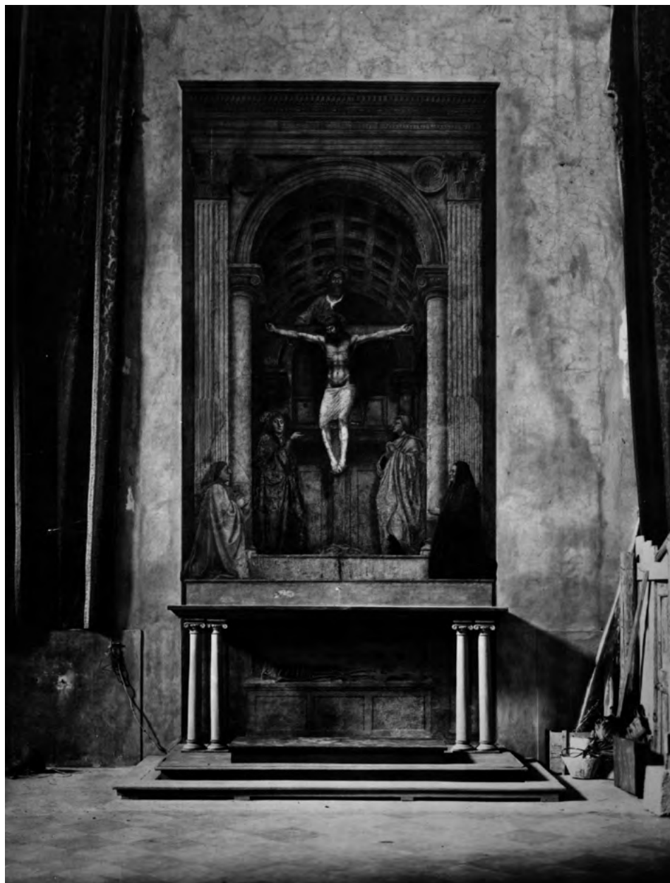
FIG. 2. Immagine del termine dei lavori di riposizionamento dell'affresco della Trinità staccato nel 1858. È ancora presente l'altare che copre lo scheletro del catafalco di Adamo. Foto del 7/11/1952 dell'archivio dell'Opificio Pietre Dure.
