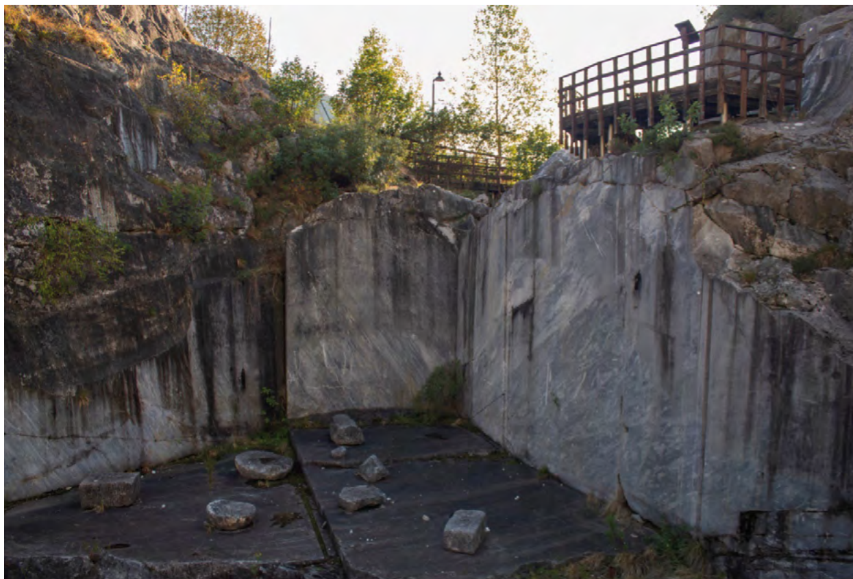
Fig. 5 - Particolare del taglio con filo elicoidale nell'Area archeologica di Fossacava (foto Autrice).
