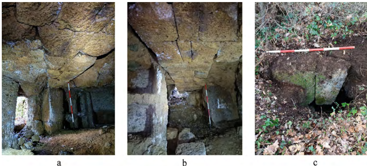
Fig. 5 - Tomba con «architrave» in blocchi di tufo a colmare una frattura nella volta: a) pilastro alla sinistra dell'ingresso; b) pilastro in fondo al corridoio destro; c) vista dall'esterno dei conci di tufo a cuneo posti sul pilastro in fondo al corridoio destro (foto E. Foddai).
