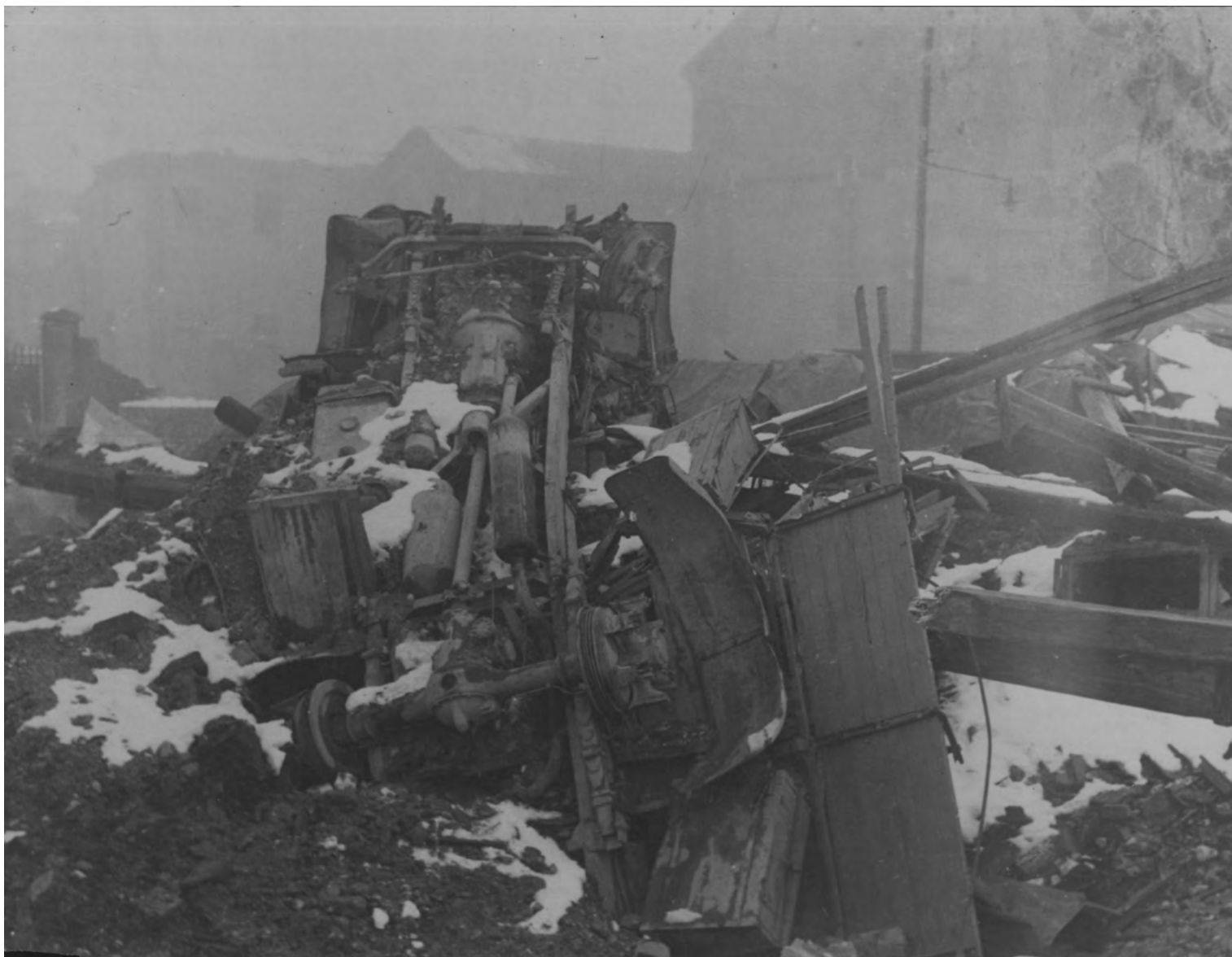
Macerie della ex-Concessionaria O.M. nella zona industriale di via Gozzi, danneggiata dai bombardamenti nell'inverno 1943-44, Padova, post 23 marzo 1944.
