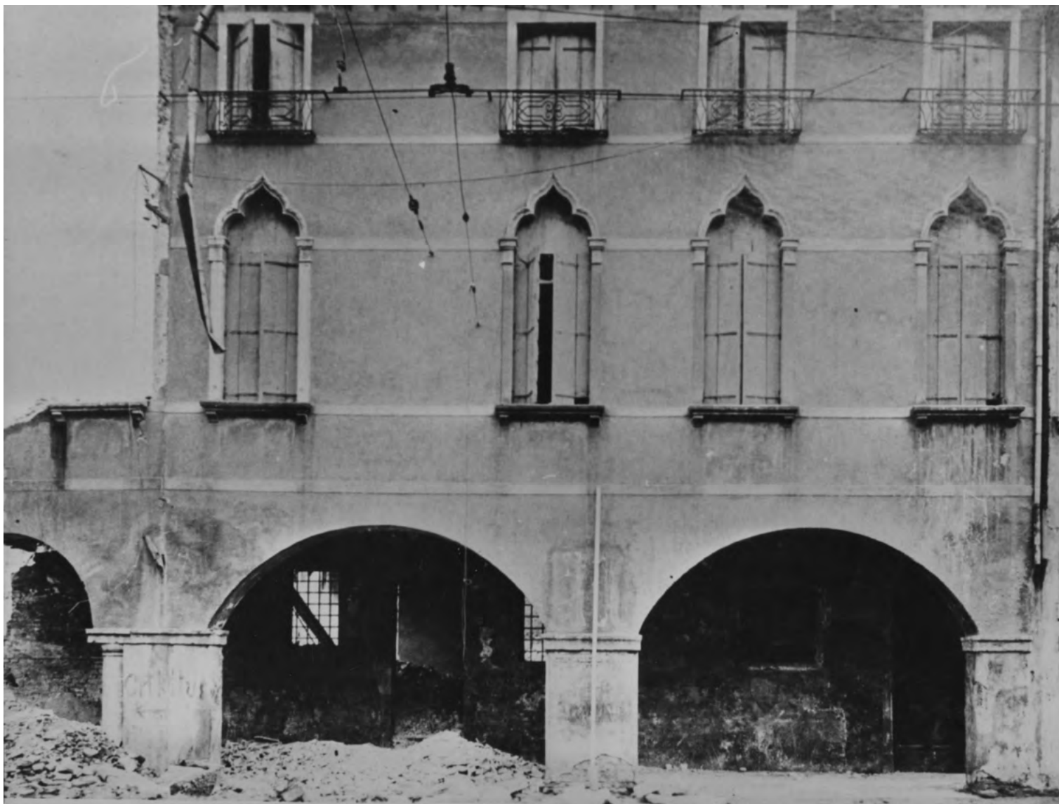
Edificio danneggiato in via Savonarola dopo il bombardamento dell'11 marzo 1944, Padova, post 11 marzo 1944.
