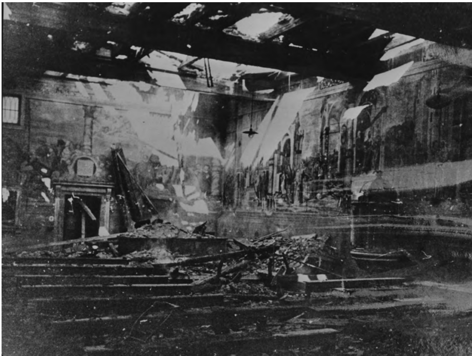
Interno della Scoletta del Carmine, con i suoi affreschi cinquecenteschi danneggiati dai bombardamenti, Padova, post 23 marzo 1944.
