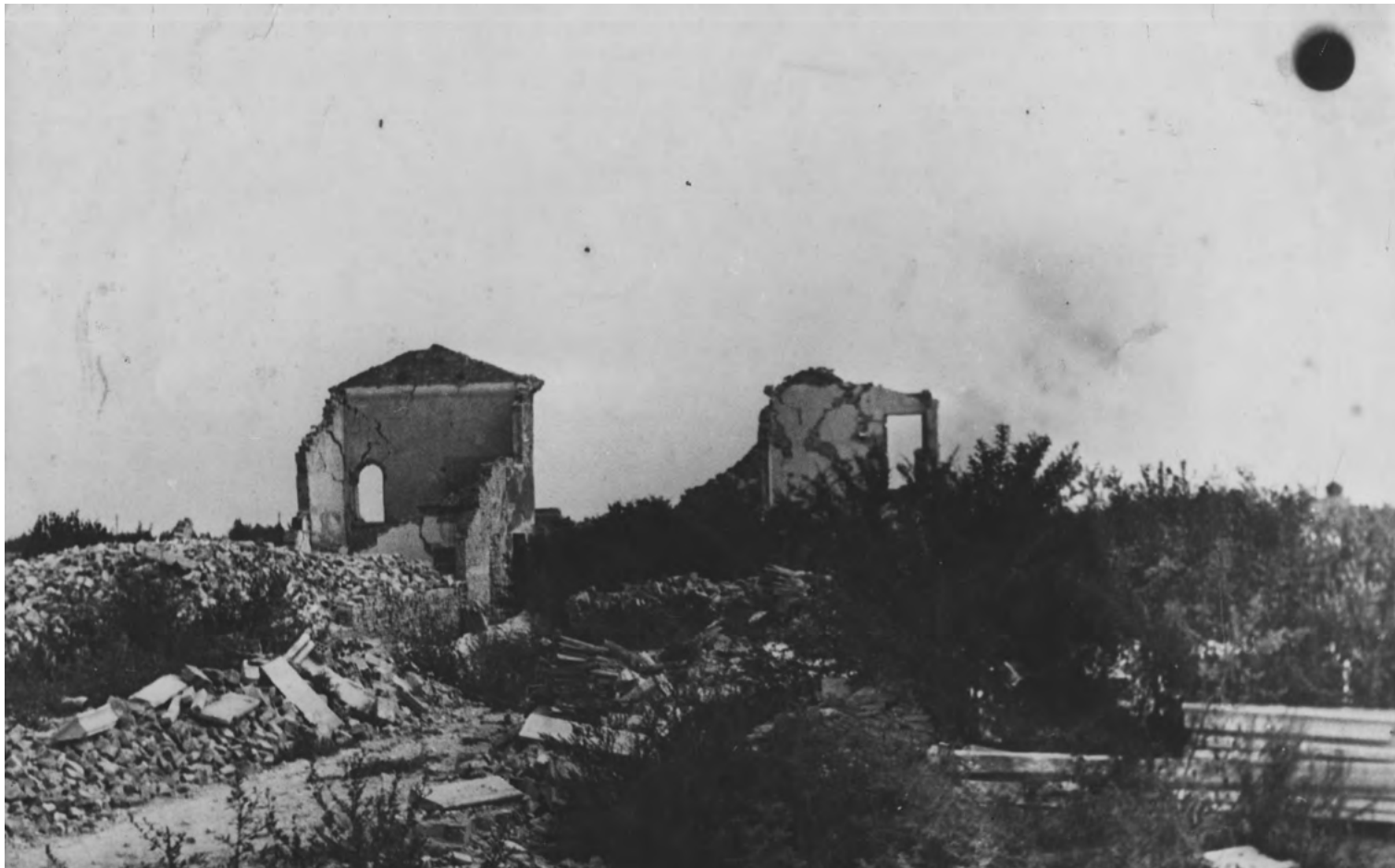
Edifici bombardati e macerie dietro la stazione ferroviaria, Padova - Arcella, post 16 dicembre 1943.
