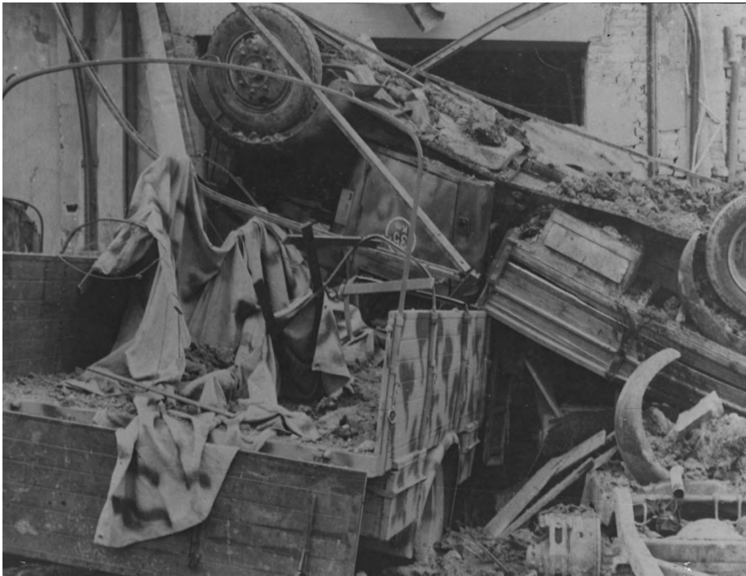
Camionetta ribaltata e macerie ex-Concessionaria O.M. nella zona industriale di via Gozzi, danneggiata dai bombardamenti nell'inverno 1943-44, Padova, post 23 marzo 1944.
