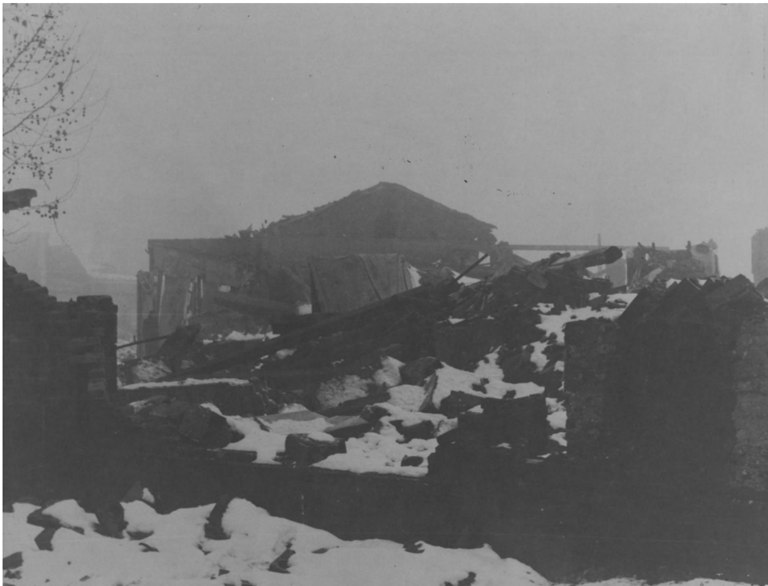
Macerie del Gasometro in via Trieste dopo i bombardamenti dell'inverno 1943/44, Padova, post dicembre 1943.
