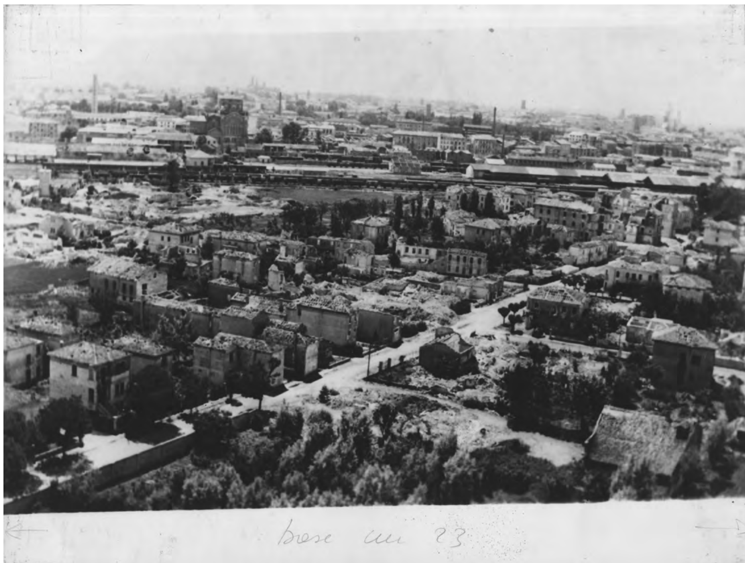
Vista dall'alto di via Giusto de' Menabuoi dopo il primo bombardamento, Padova - Arcella, post 16 dicembre 1943.
