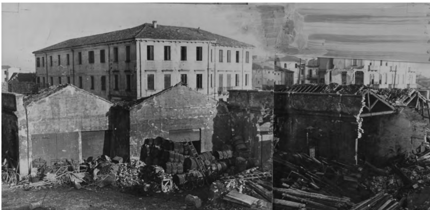
La storica distilleria Lino Bortolozzi nei pressi della stazione ferroviaria dopo il primo bombardamento, Padova, post 16 dicembre 1943.
